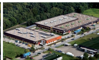
Planta de mecanizado NORD Gadebusch
